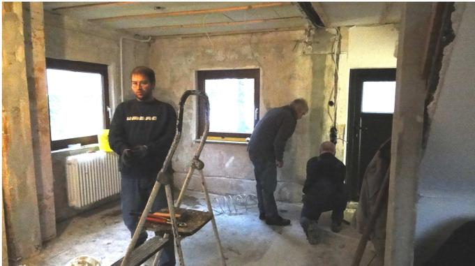
und Türen eingesetzt. Eine neue Tür für den zukünftigen Tagesraum wurde auf der Hausrückseite eingebaut, Zimmerwände für den neuen Tagesraum entfernt. In der Küche
